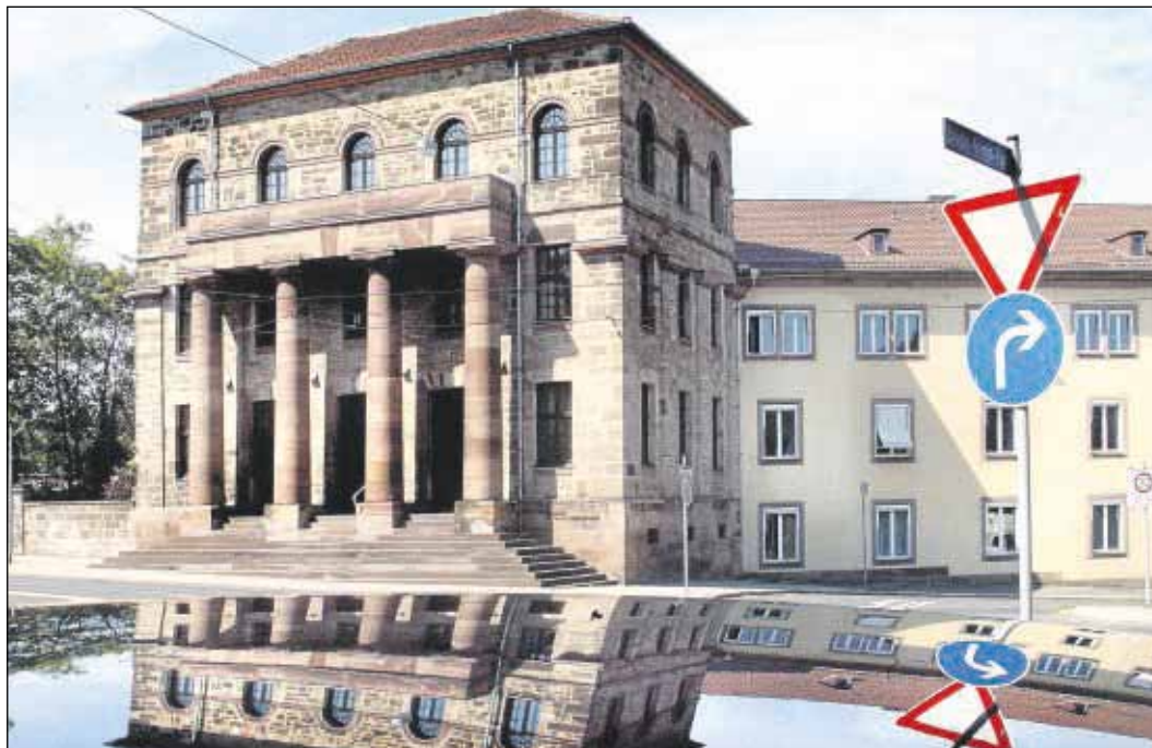
Ist noch Sitz des Verwaltungsgerichtshofs: In der Torwache links könnte die Wohnung der Grimms rekonstruiert werden. Der benachbarte Nachkriegsbau soll abgerissen werden. Archivfoto: Koch
