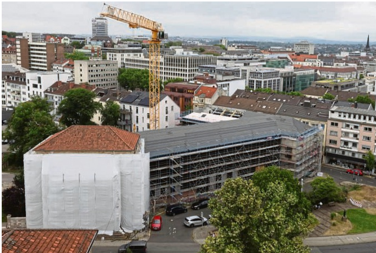
Torwache hinter weißen Planen: Von außen ist kaum zu sehen, dass im und am Museumsneubau derzeit Bauleute von etwa einem Dutzend Gewerken gleichzeitig zugange sind.
